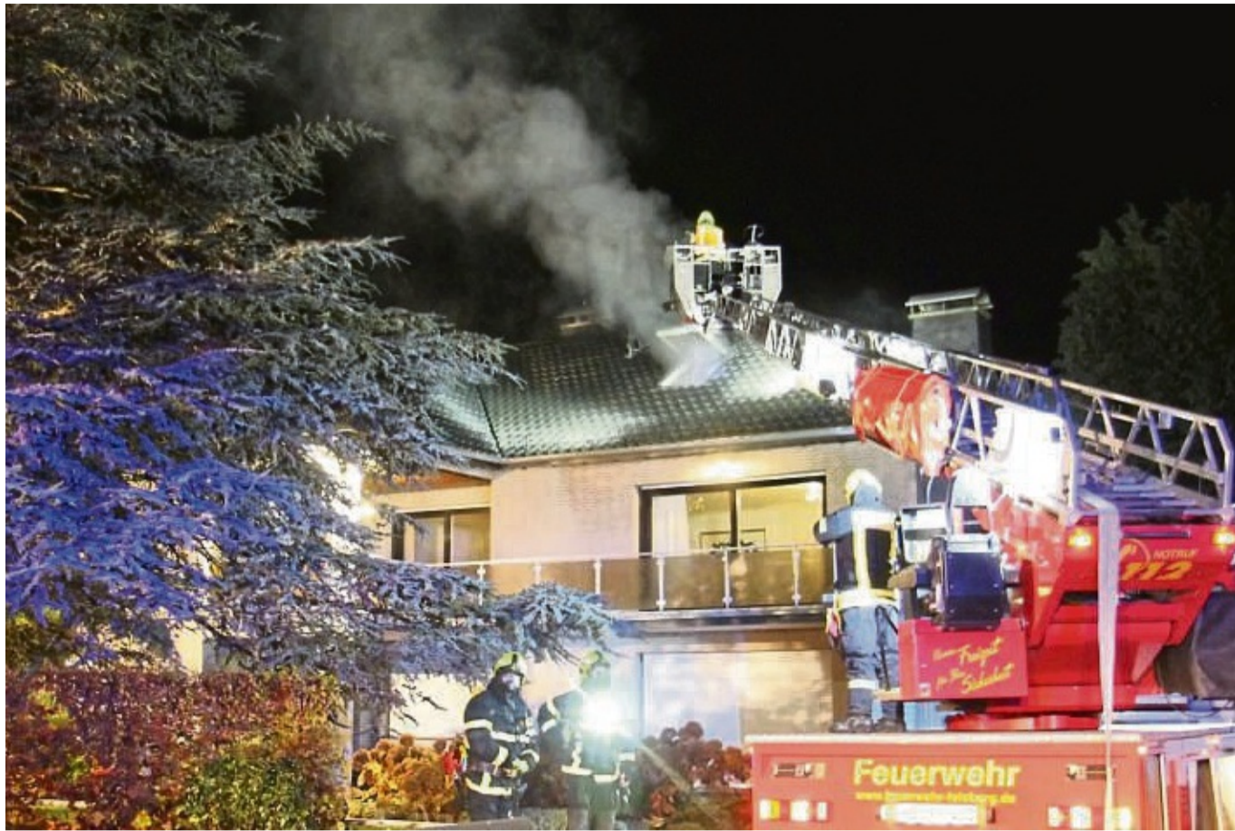
Stark verrußt ist das Dachgeschoss des betroffenen Hauses in Felsberg.
