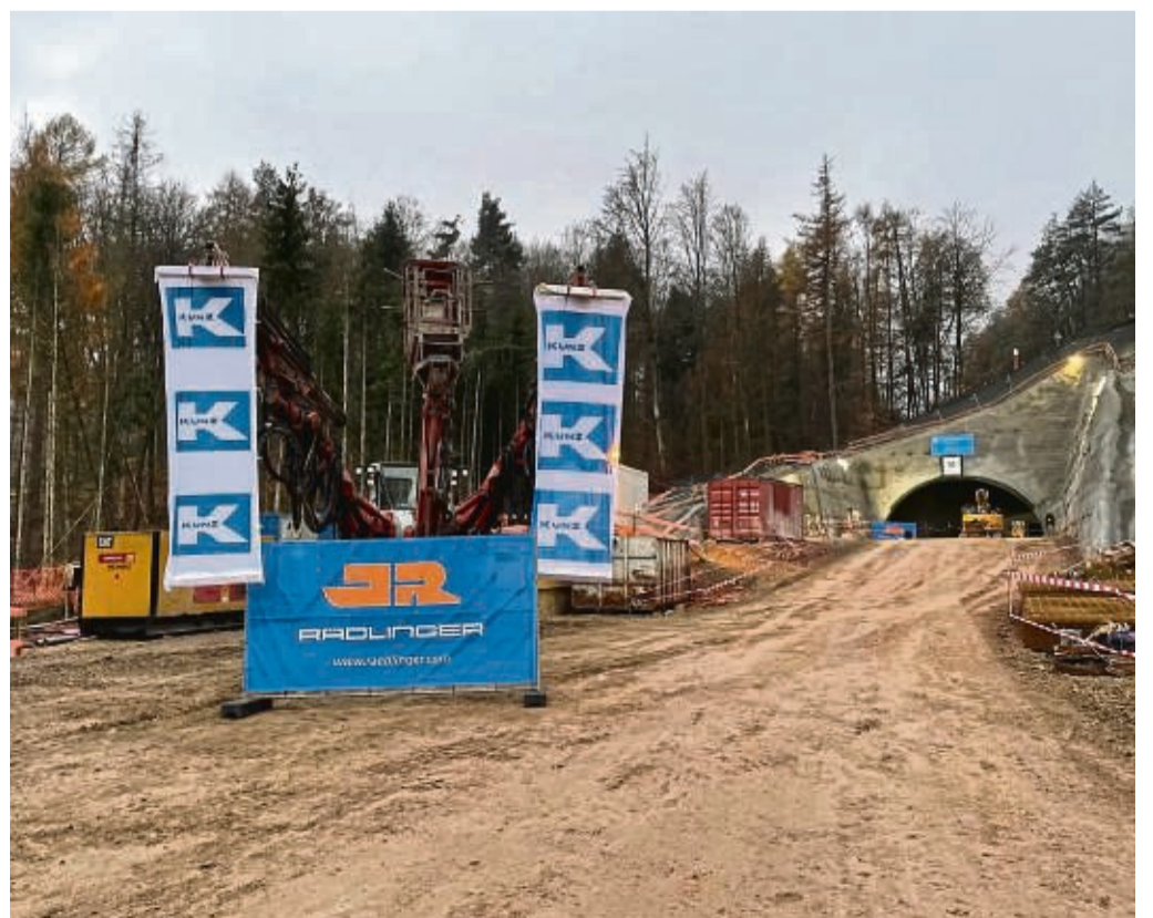
Anstich Alberbergtunnel bei Herleshäuser-Unhausen: Der Bau der Autobahn A44 schreitet weiter voran. FOTO: PRIVAT/INH
