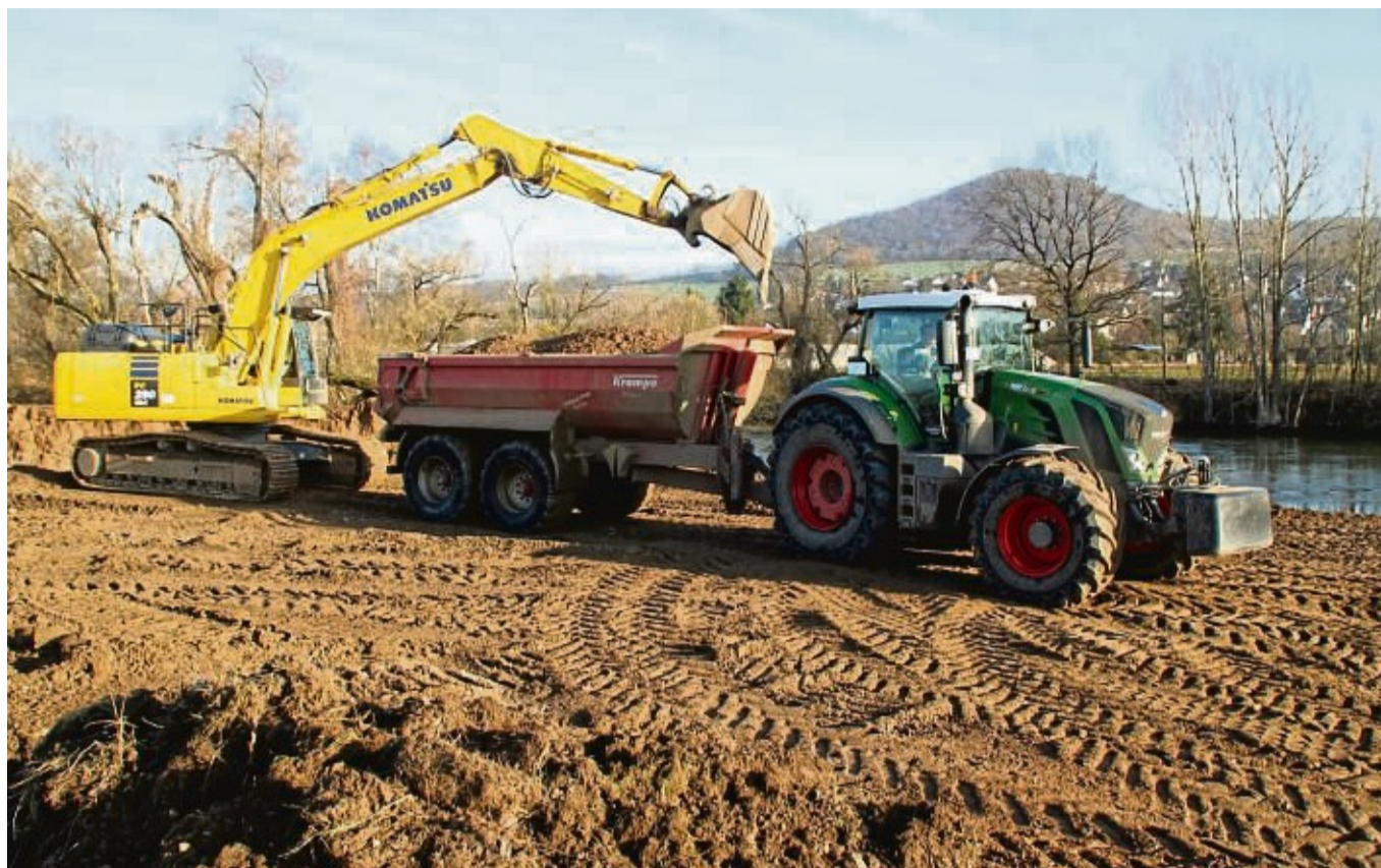
Großgerät im Einsatz: An der Eder bei Felsberg werden Erde und Kies ausgebaggert, damit der Fluss im Sinne des Umweltschutzes „naturnäher“ wird, wie es im Fachjargon heißt. Der Mutterboden kommt größtenteils auf Ackerflächen, der Kies wird in und an der Eder wieder eingebaut.
