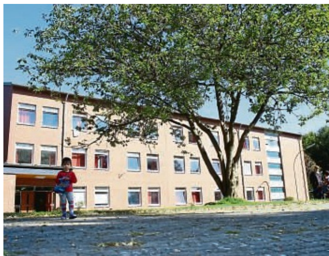
Die Pommernanlage in Wolfhagen wurde von der ehemaligen Kaserne zur Flüchtlingsunterkunft.
