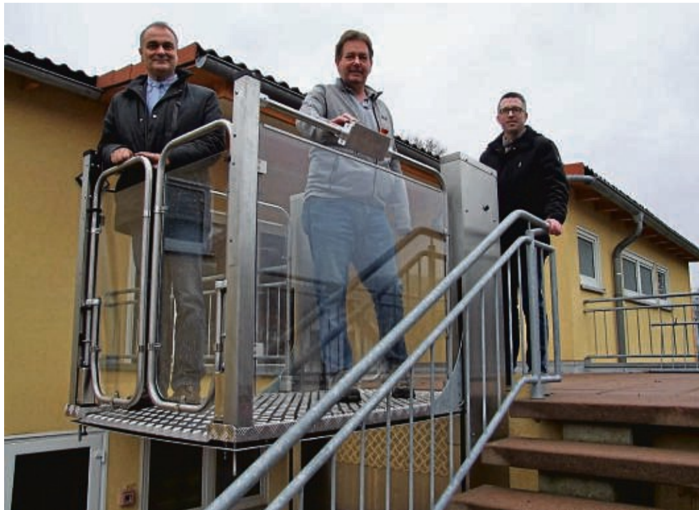
Barrierefrei in die obere Etage: Bürgermeister Klaus Gier, Ortsvorsteher Rainer Pfeffermann und Bauamtsleiter Alexander Paul (von links) nahmen an der Fassade des Dorfgemeinschaftshauses in Affoldern einen Hebeplattformlift in Betrieb.
