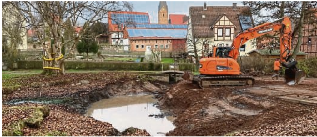
Der Stadtpark in Mengeringhausen wird im Rahmen des Förderprogramms Dorfentwicklung umgestaltet. Als erste Maßnahmen werden die Teichanlage zurückgebaut und Wegebauarbeiten ausgeführt.
