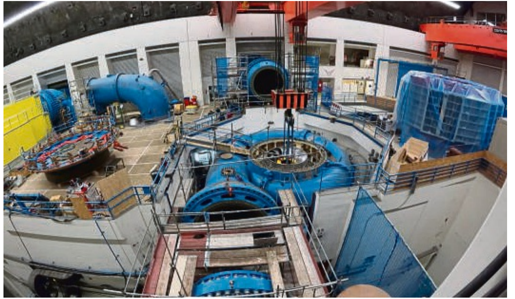
Revision im Pumpspeicherkraftwerk Waldeck II: Über 20 Millionen Euro hat Kraftwerksbetreiber Uniper in die Einsatzbereitschaft investiert. Das Bild entstand beim Ausheben der Turbine. FOTO: UNIPER/PR
