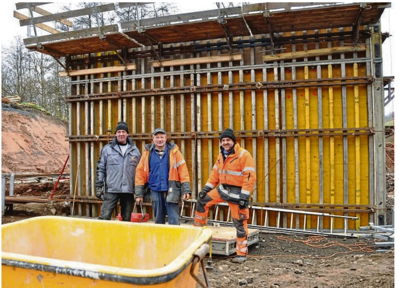
Sie bauen die Schalung für die Brückenelemente: von links Frank Haller, Jörg Giesecke und Baustellenleiter René Hillert.
