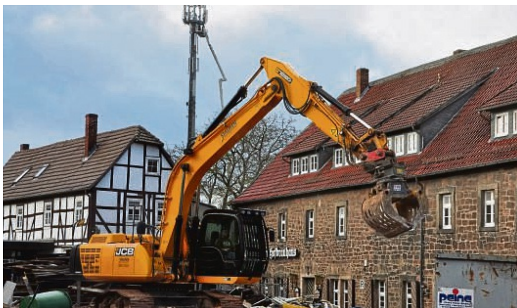
Abbrucharbeiten auf Brauereigelände. Im Hintergrund Arbeiten am Telekom-Masten.
