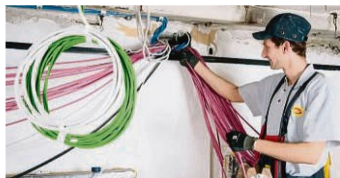
E-Check im Altbau.
