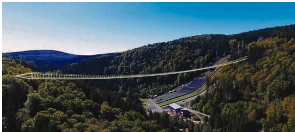
Die längste Hängebrücke der Welt nimmt Gestalt an: So soll der „Skywalk“ – hier eine Bildmontage – zwischen dem Willinger Mühlenkopf und dem Usselner Musenberg aussehen. Als erstes werden die Verankerungen gebohrt.
