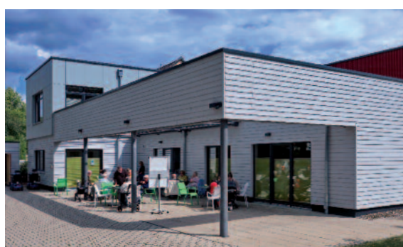
Aufstockung Gebäude Kinderschutzbund
