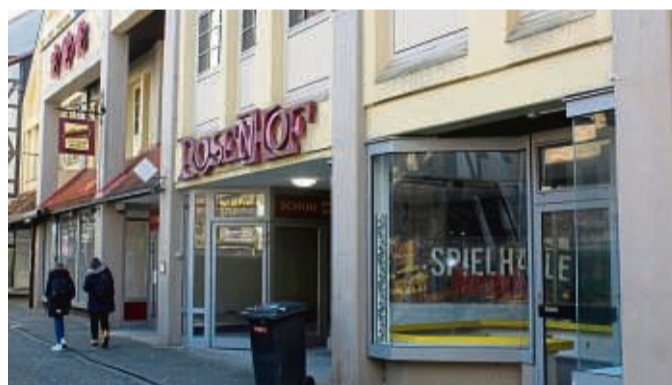
Baustelle: Blick auf den Rosenhof. Die Ladenflächen im Rosenhof standen zuletzt bis auf die Spielhalle leer.
