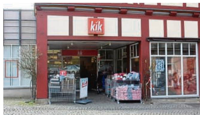
Der bisherige Standort: die Filiale des Textil-Discounters Kik an der Langen Straße.
