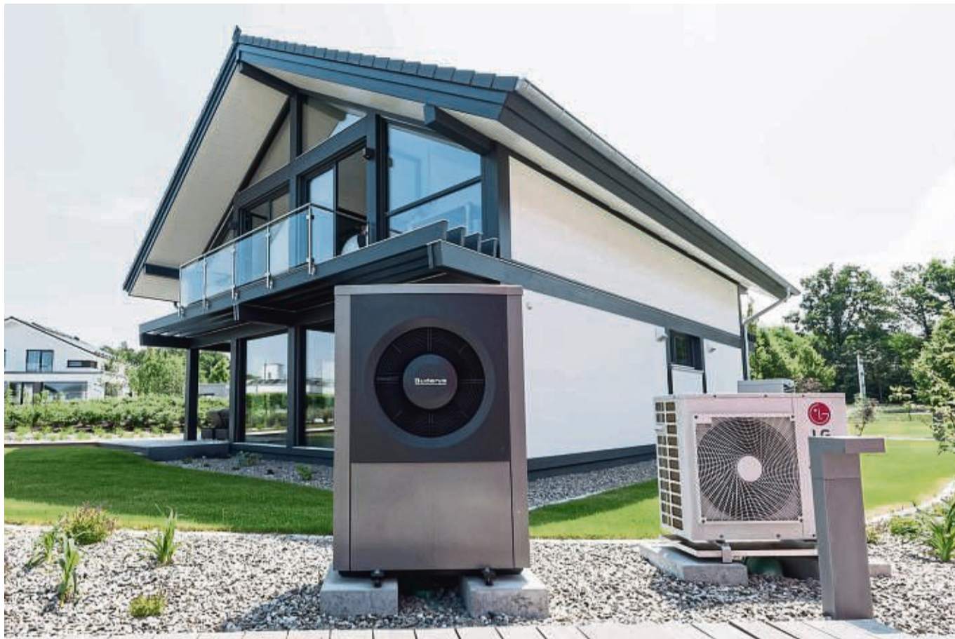
Wärmepumpen sind in privaten Neubauten der neue Heizungsstandard: Für Altbauten sind sie aber noch nicht immer das richtige. FOTO: DANIEL MAURER/DPA-TMN
