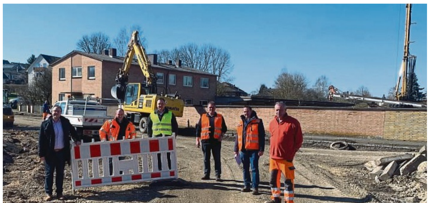
Im Industriegebiet Seegel wird saniert: (von links) Bürgermeister Thomas Eckhardt, Günther Schneider und Sven Quasdorf von der Firma Strabag, Stefan Morgenthal (KMO Ingenieure), Andre Assenmacher (Bauamt Stadt Sontra) sowie Polier Uwe Walther. FOTO: PRIVATINH
