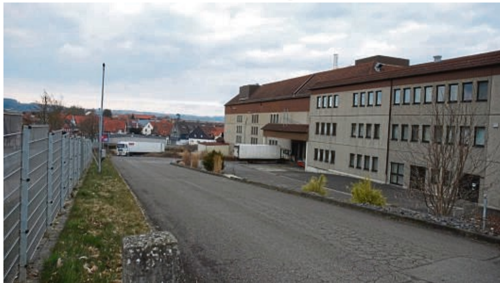
Fünf Millionen Euro werden für Abbruch und Entsorgung der Wurstfabrik Wilke in Berndorf mit den Beton- und Asphaltflächen veranschlagt.
