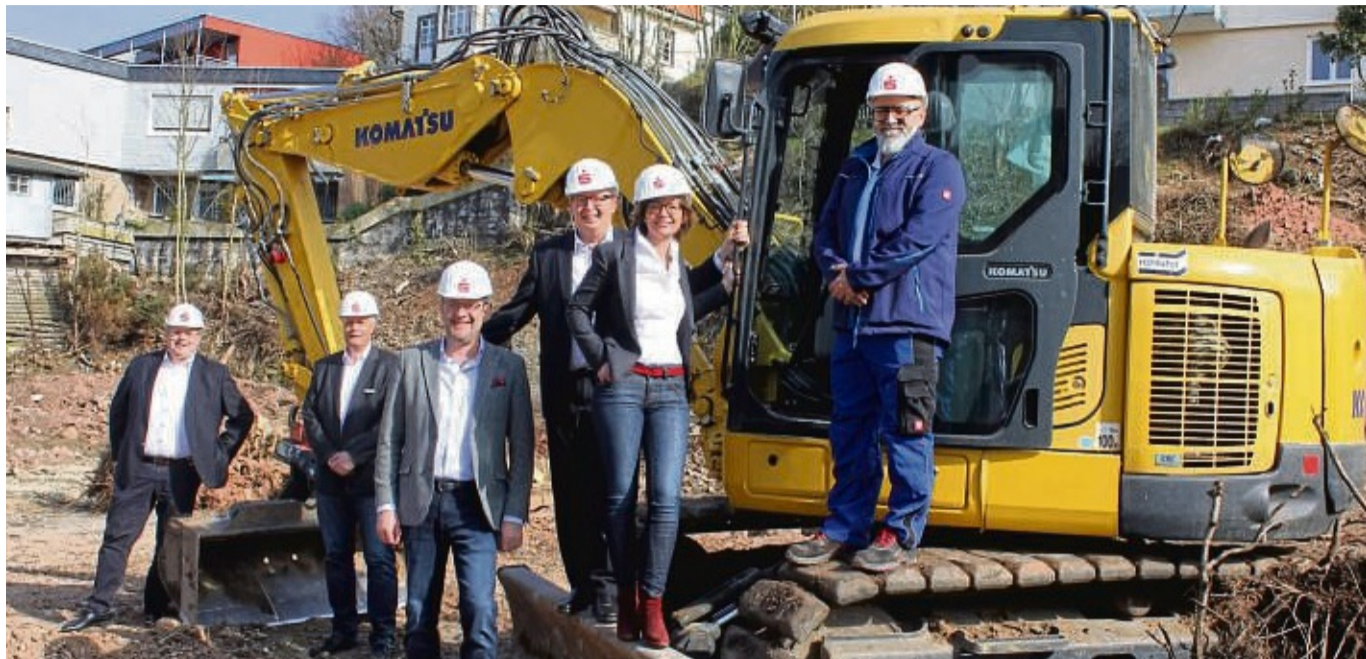
Freuen sich über den Baubeginn am ehemaligen Bergschlösschen in Hann. Münden: Torsten Rohmann (von links), Uwe Drebing, Patrik Beckmann, Thomas Scheffler und Sonja Schafflik von der Sparkasse Göttingen sowie der Bauherr und Bauträger Bayram Er aus Hann. Münden.
