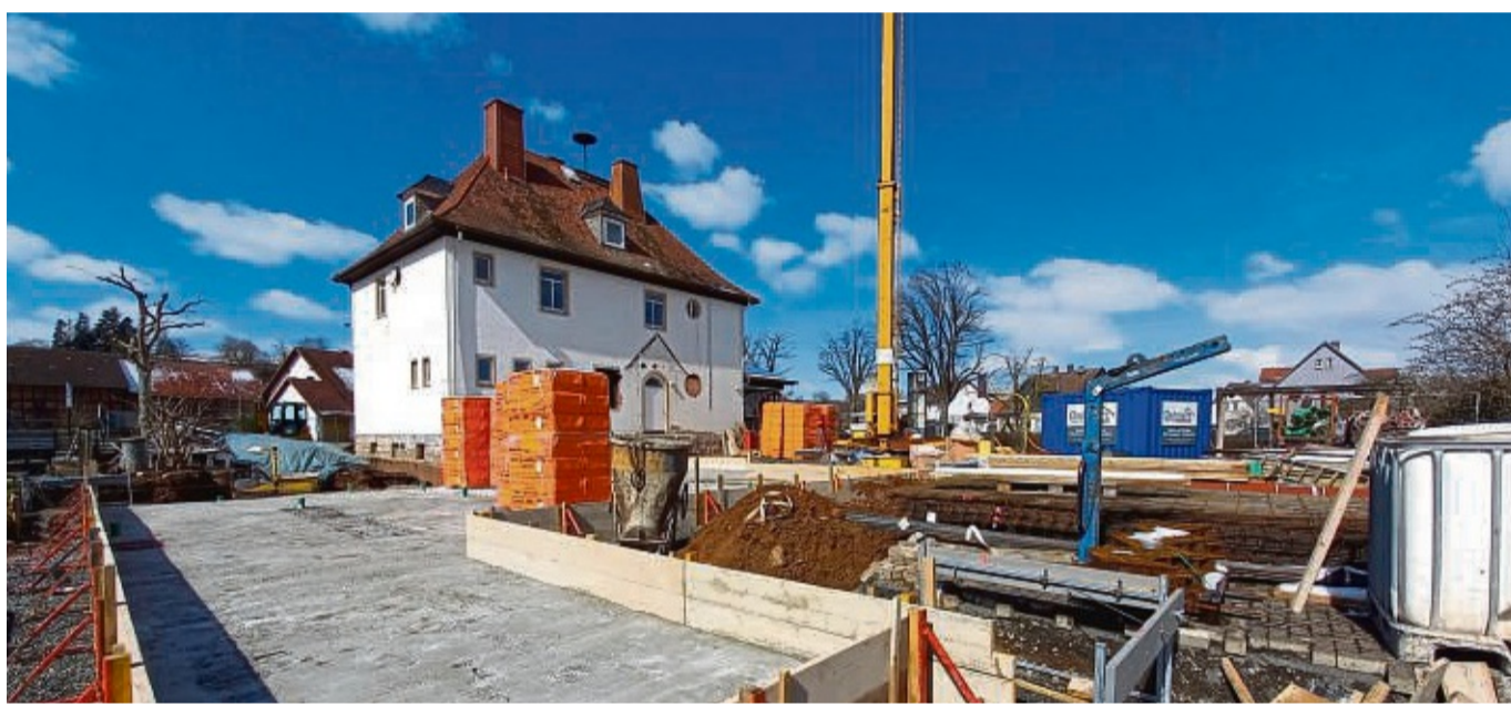
Wird wohl sehr viel teurer als gedacht: Sanierung des DGHs und Neubau des Feuerwehrhauses als Kombinationsprojekt in Anraff.
