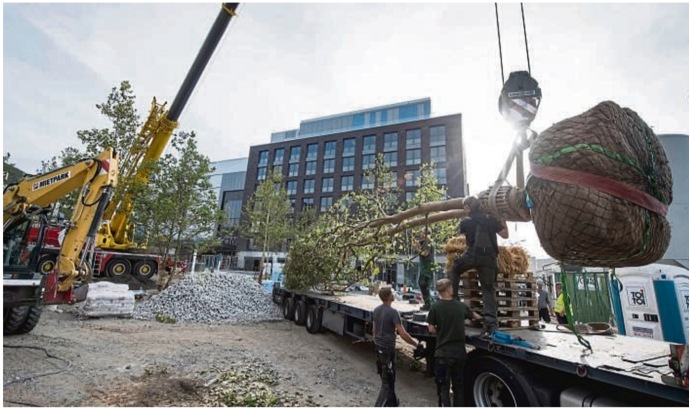
Kommt ein Kran zum Einsatz, muss man darauf achten, dass die Rinde nicht zu stark gequetscht wird. Sonst kann es passieren, dass sie abstirbt.
