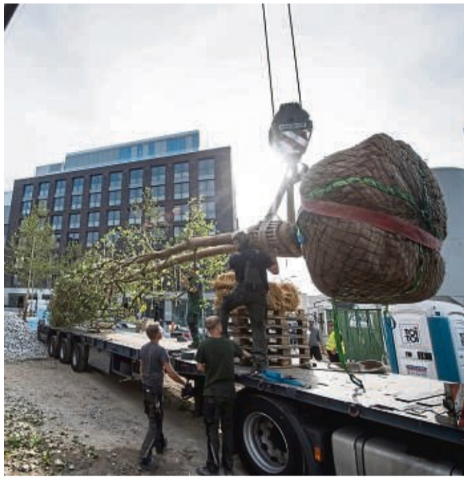
Kommt ein Kran zum Einsatz , muss man darauf achten, dass die Rinde nicht zu stark gequetscht wird. Sonst kann es passieren, dass sie abstirbt.
