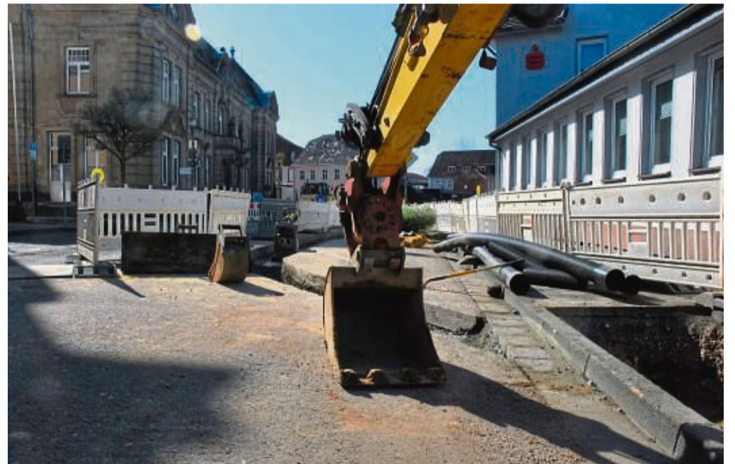
Versorgungsleitungen der Energie Waldeck-Frankenberg werden derzeit in der Rauchstraße Bad Arolsen verlegt. Danach werden die Straßen rund um den Kirchplatz saniert.
