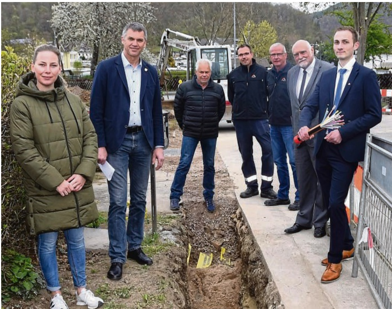
Die ersten Leerrohre verlegt: Mitarbeiter von EWF, Stadt Waldeck und Bauunternehmen beim Start der Vereinbarung auf Scheid, von links Carolin Knipschild, Bürgermeister Jürgen Vollbracht, Reinhold Seeler, Meik Schmid, Dieter Priebnitz, EWF-Geschäftsführer Stefan Schaller und Nick Schieferdecker.
