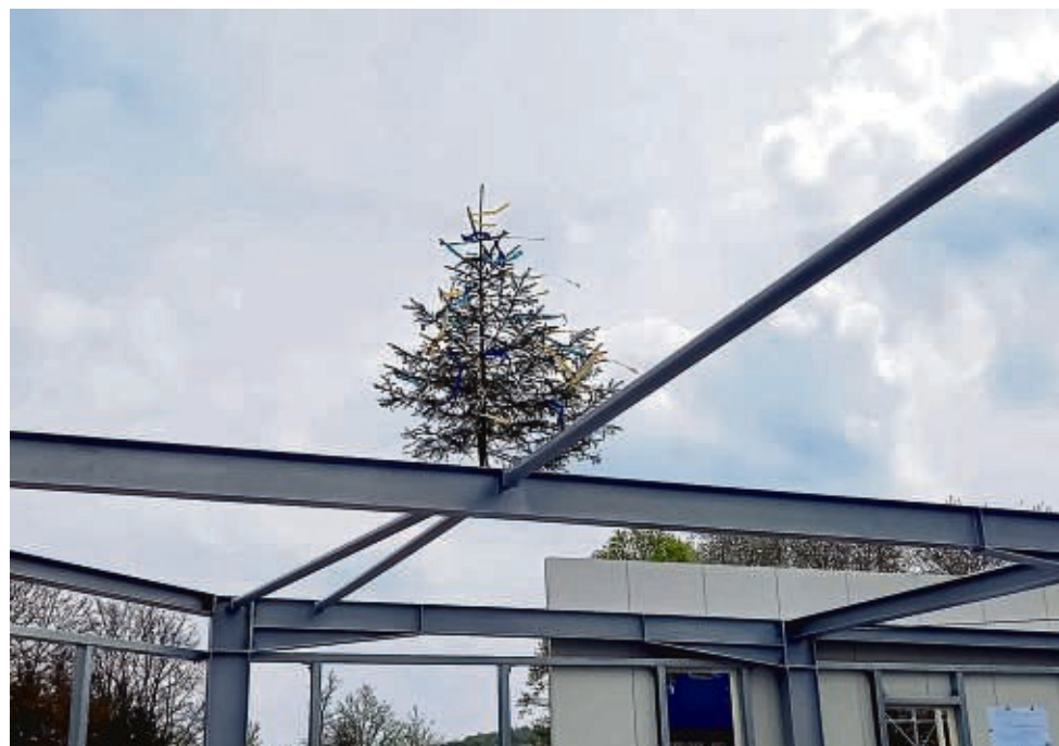
Der Richtbaum steht! Ein großer Augenblick für die Firma.
