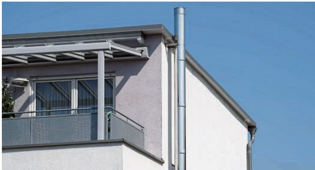
Hoch hinaus: Neue Schornsteine müssen den höchsten Punkt des Dachs um mindestens 40 Zentimeter überragen.
