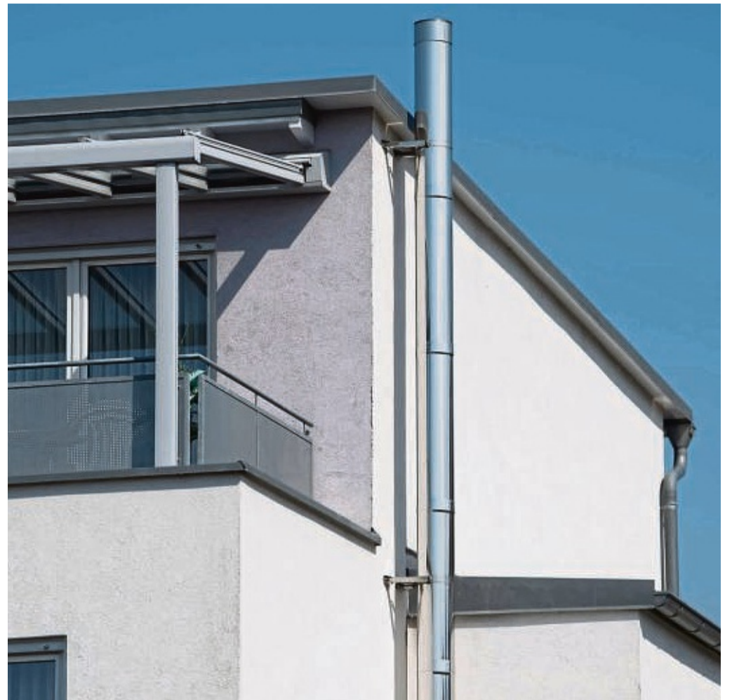
Hoch hinaus: Neue Schornsteine müssen den höchsten Punkt des Dachs um mindestens 40 Zentimeter überragen.
