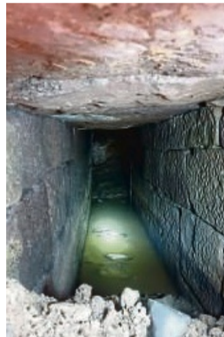
Alter Kanal unter dem Marktplatz, an den Wänden ist noch die einstige Höhe des Wasserstands erkennbar.
