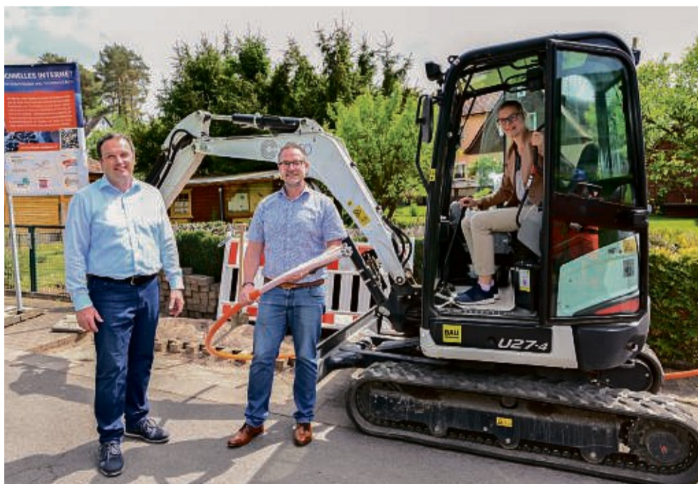
Baustart für die direkten Glasfaseranschlüsse (FTTB - Fiber to the building, d.h. Glasfaserausbau bis ins Gebäude) in Sontra-Krauthausen und Thurnhosbach (v.l.n.r.): Herr Volker Becker (Geschäftsführer des Generalunternehmers visco GmbH), Herr Bürgermeister Thomas Eckhardt (Bürgermeister der Stadt Sontra) und Frau Kathrin Laurier (Geschäftsführerin der Breitband Nordhessen GmbH) © Breitband Nordhessen GmbH / Fotograf: Harry Soremski
