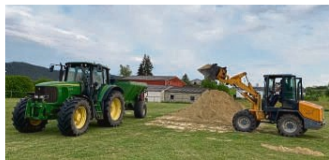
Mit schwerem Gerät wurden mehr als 50 Tonnen Sand für perfekte Reit-Bedingungen aufgebracht. FOTO: REIT- UND FAHRVEREIN
