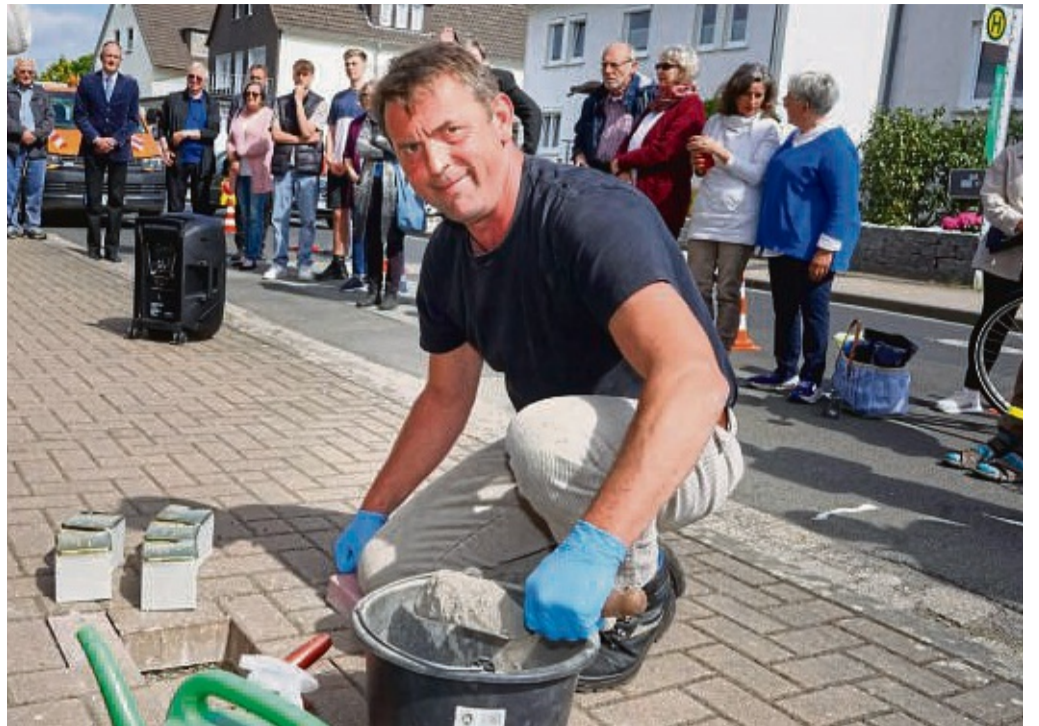
Michael Schinko verlegte gemeinsam mit seinen Bauhofkollegen die vorerst letzten Stolpersteine in Zierenberg.
