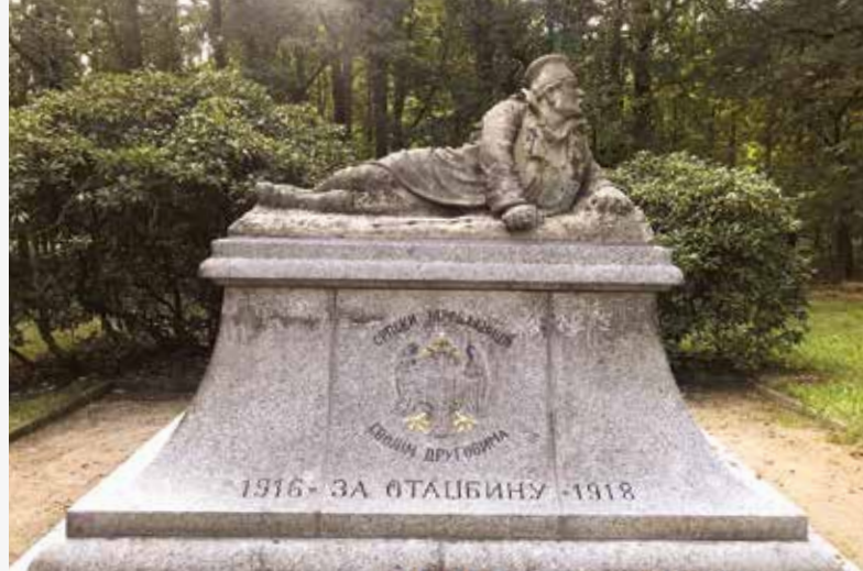
▲ Das sanierte Denkmal des „Verwundeten Serben“.
