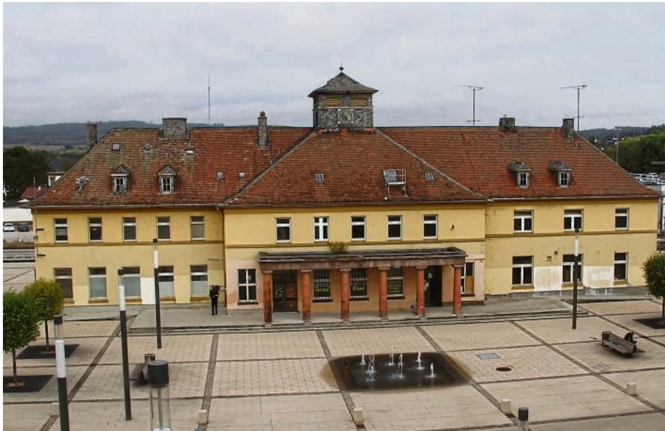
Das alte Bahnhofsgebäude in Frankenberg soll bis 2024 umgebaut werden, dann sollen dort die Musikschule Frankenberg und die Stadtbücherei einziehen. FOTOS: GERHARD MEISER
