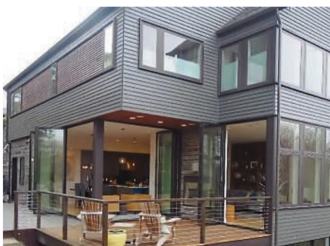
Das Zusammenspiel von Form und Farbe der Fensterelemente erzeugt eine eigene Wirkung auf das Erscheinungsbild eines Hauses.
