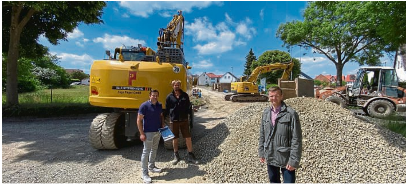
Bauarbeiten nach Plan: (von links) Bauamtsleiter der Gemeinde Breuna, Kai Päckert, Polier Sascha Kreis vom Unternehmen Pieper aus Korbach und Breunas Bürgermeister Jens Wiegand an der Baustelle in Oberlistingen. FOTO: MONIKA WÜLLNER
