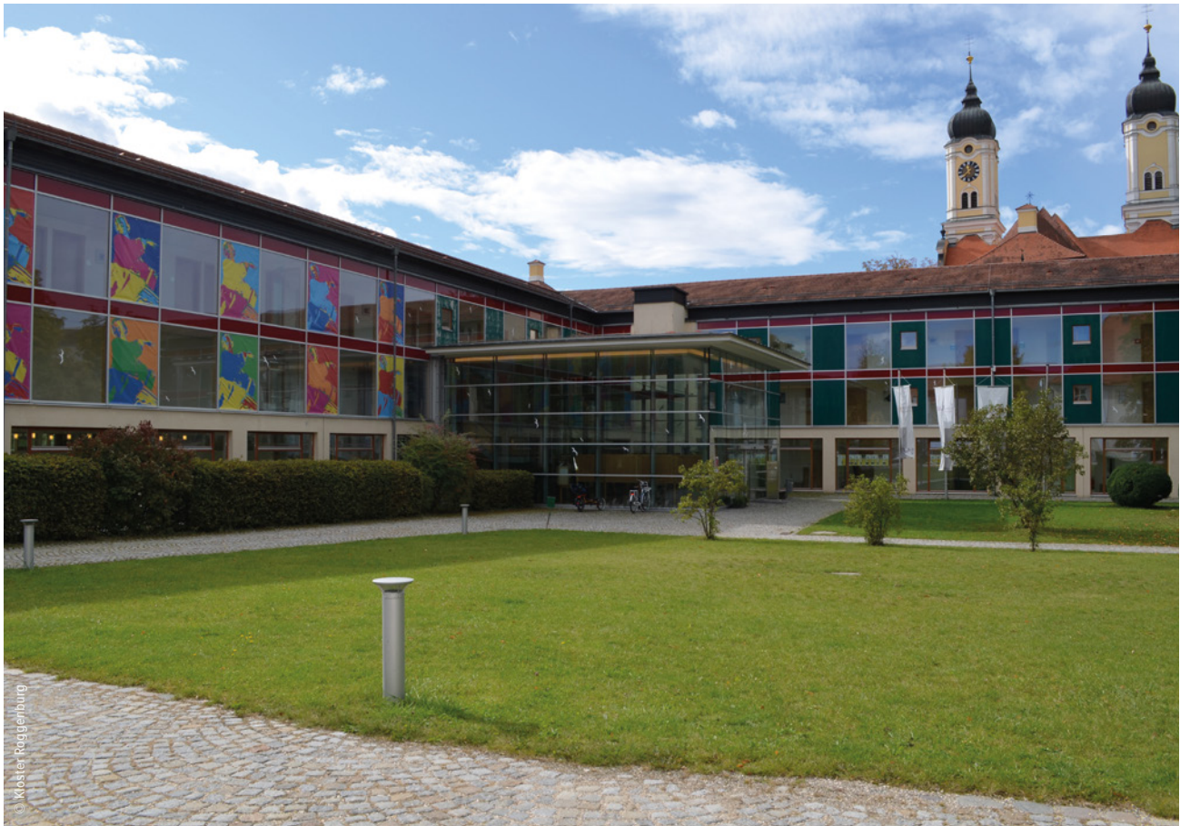
Das Umweltzentrum Kloster Roggenburg wurde im Niedrigenergiestandard erbaut
