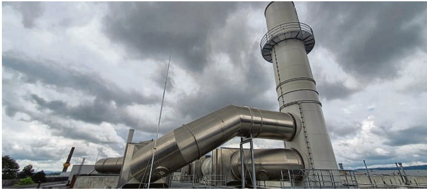
Die Abluft aus dem Werk wird gebündelt, behandelt und abgeleitet, um Geruchsemissionen zu reduzieren. FOTO: LUTZ BENSELER
