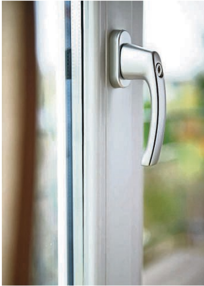
Ein verschließbarer Fenstergriff erhöht die Einbruchhemmung.
