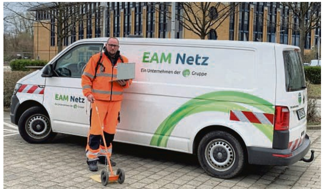
Lecks auf der Spur: Kevin Hesse von der EAM Netz überprüft in Melsungen und Spangenberg die Gasleitung. FOTO: EAM
