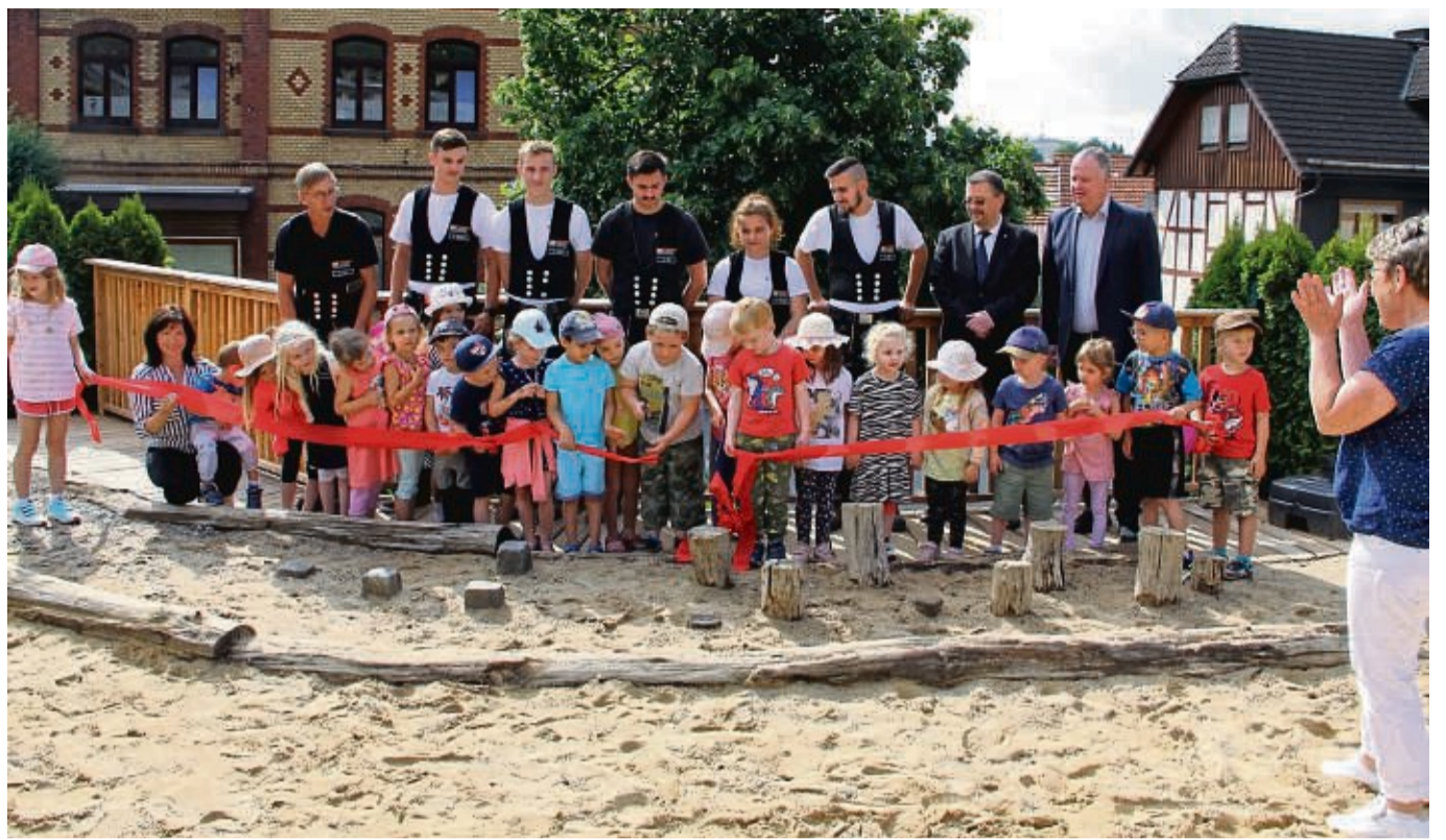
Einweihung auf der neuen Brücke: Auszubildende von Finger-Haus haben auf dem Spielplatz der DRK-Kita in Battenberg eine Brücke mit Geländer gebaut. Im Bild einige Kinder mit (stehend von links) Finger-Haus-Ausbilder Alexander Roth, den beteiligten Azubis Tom Spellner, Tom Platte, Tristan Beil, Paulina Schicke und Moritz Beil sowie DRK-Geschäftsführer Christian Peter, Bürgermeister Christian Klein und vorne rechts Kita-Leiterin Wilfriede Frank.
