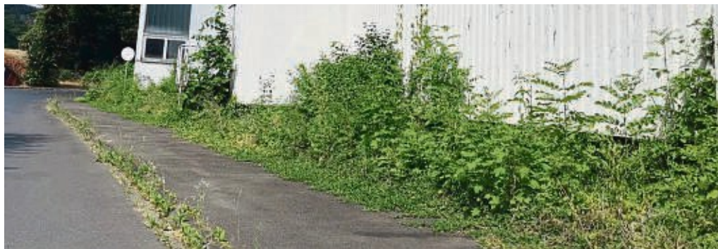
So soll es nicht aussehen: Die Stadt Sontra fordert zur regelmäßigen Straßenreinigung sowie der Durchführung von Pflegemaßnahmen an Bäumen und Sträuchern. FOTO: STADT SONTRA
