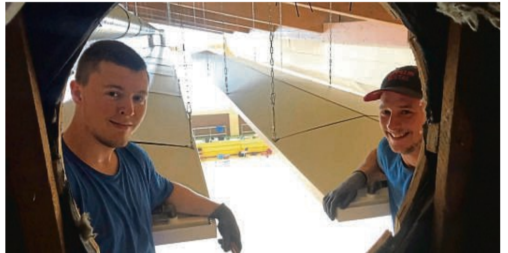
Die neuen Deckenstrahlplatten sind montiert: In der Sporthalle der Walter-Lübcke-Schule in Wolfhagen wird die Heizungs- und Lüftungsanlage ausgetauscht. Azubi Tim Lengemann (links) und Anlagenmechaniker Paul Meyer der Firma Ochs in Wabern nehmen den Austausch vor.
