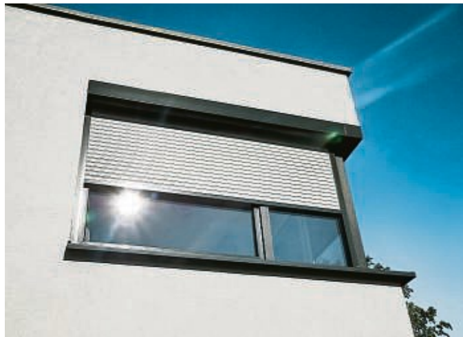
Außenliegender Sonnenschutz, wie etwa Rollläden, wirkt meist am besten gegen Sommerhitze.
