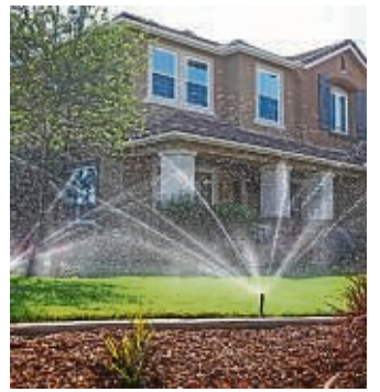
Regen auf Bestellung: Automatische Bewässerungssysteme pflegen das Grün bei sparsamer Dosierung.
