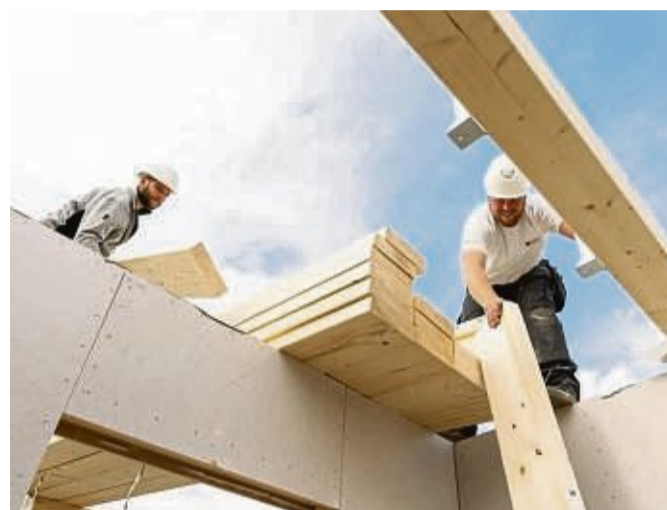
Mehr als 900 Mitarbeitende verwirklichen etwa 750 Hausräume pro Jahr. Dabei ist jedes Finger-Haus ist ein Unikat.
