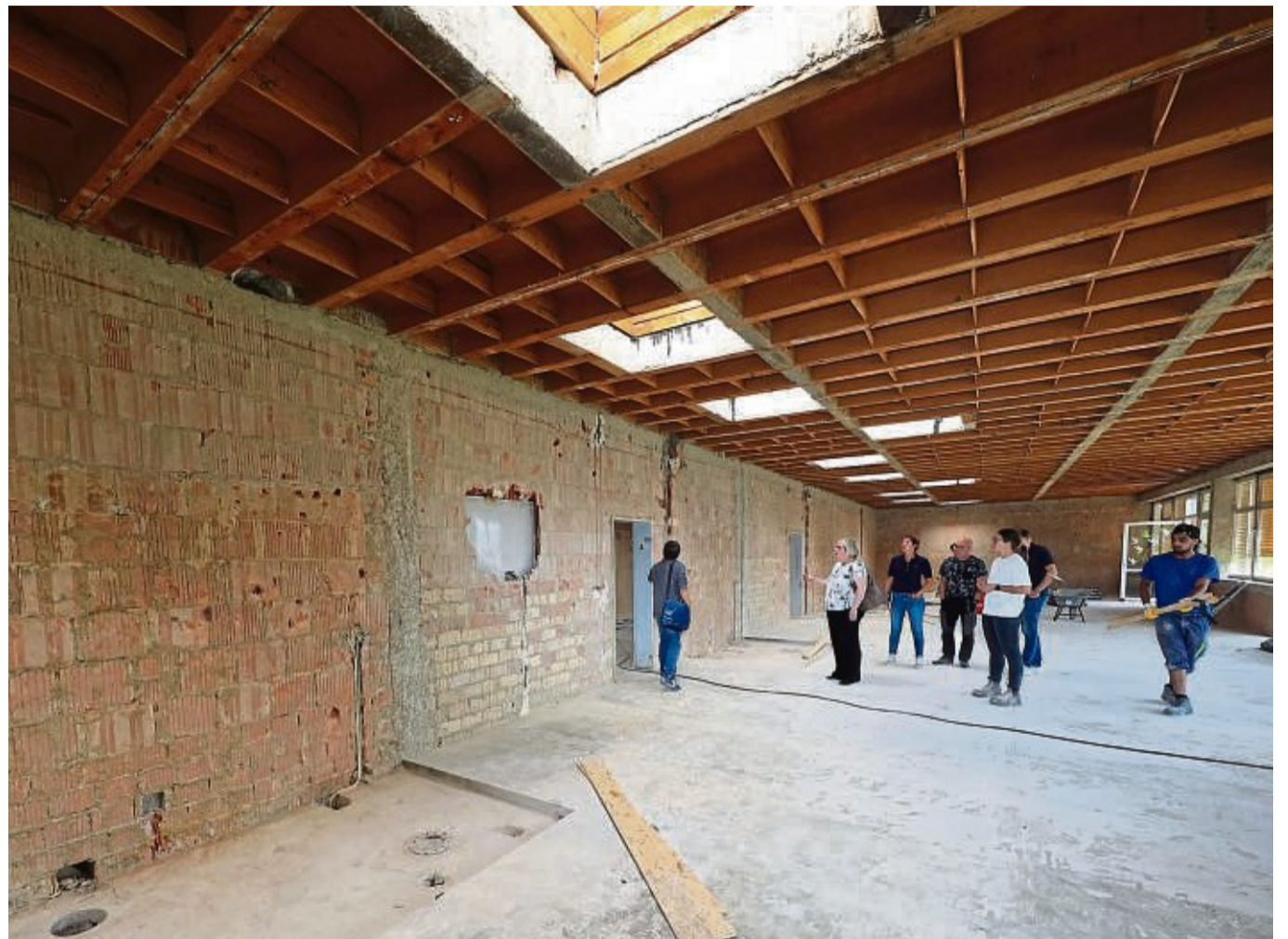
Fast eine Sporthalle: Nach dem vorübergehenden Abbau aller nichttragenden Zwischenwände im Klassentrakt der Kollwitz-Schule kann man den gesamten Bereich (hier drei von sechs Räumen) überblicken. FOTO: THOMAS THIELE
