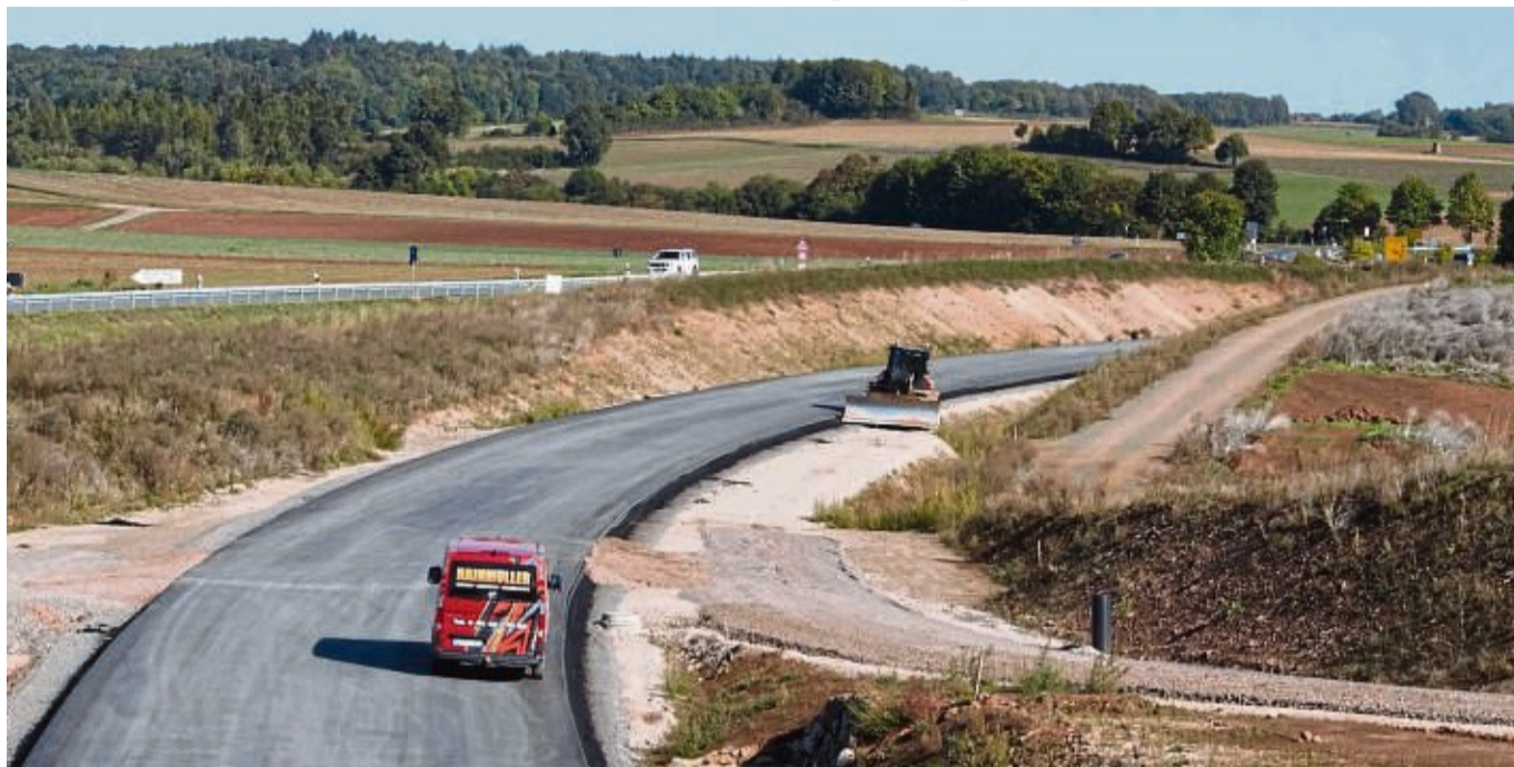
Der Blick von der Rampe in Richtung Korbach: Die Asphaltierungsarbeiten auf der Hauptstrecke wurden planmäßig abgeschlossen. FOTO: SARAH VOLK
