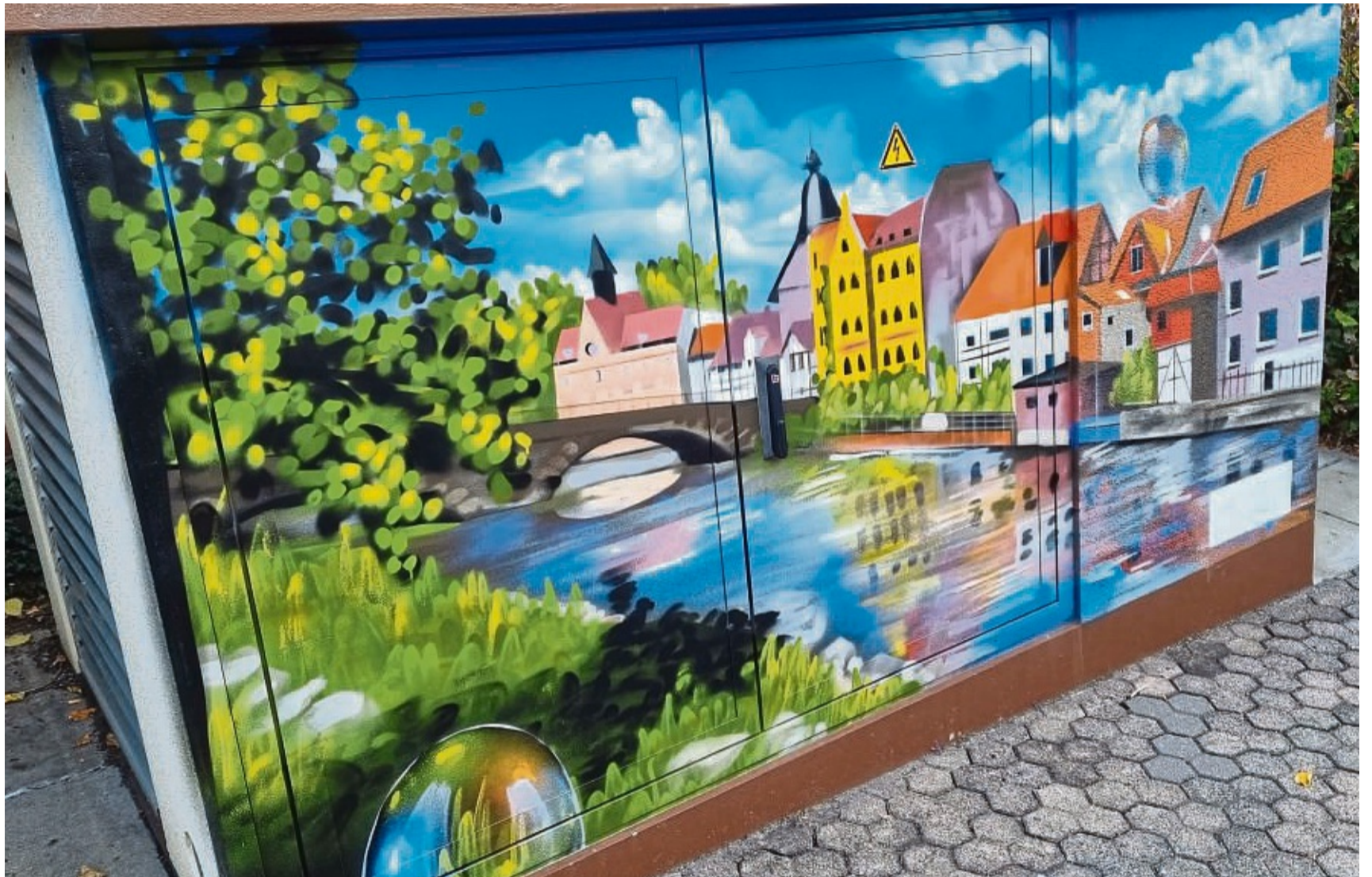
Graffiti zieren die Stromkästen in Eschwege: Der Sprayer Ilja van Treeck aus Leipzig hat an die bekannten Stadtbilder auf Trafostationen gesprüht.
