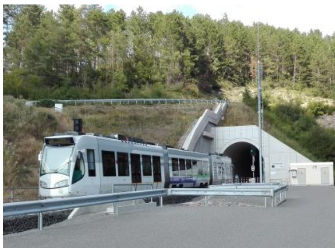
Neuer und alter Tunnel Foto: Horst Röhling
