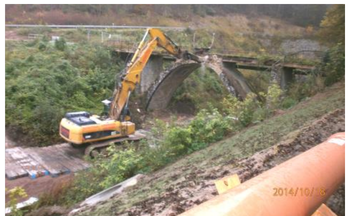
Abriss der Brücke
