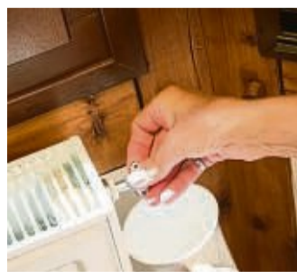
Zum Entlüften der Heizung wird das Ventil mit einem Vierkant Schlüssel aufgedreht. FOTO: CHRISTIN KLOSE/DPA-TMN
