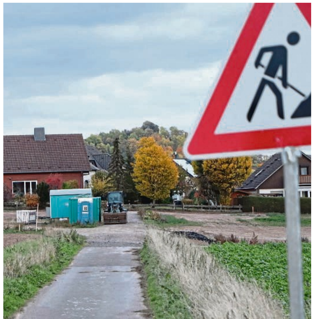
Das Baugebiet „Wassergraben“ in Grebenstein wird derzeit erschlossen.
