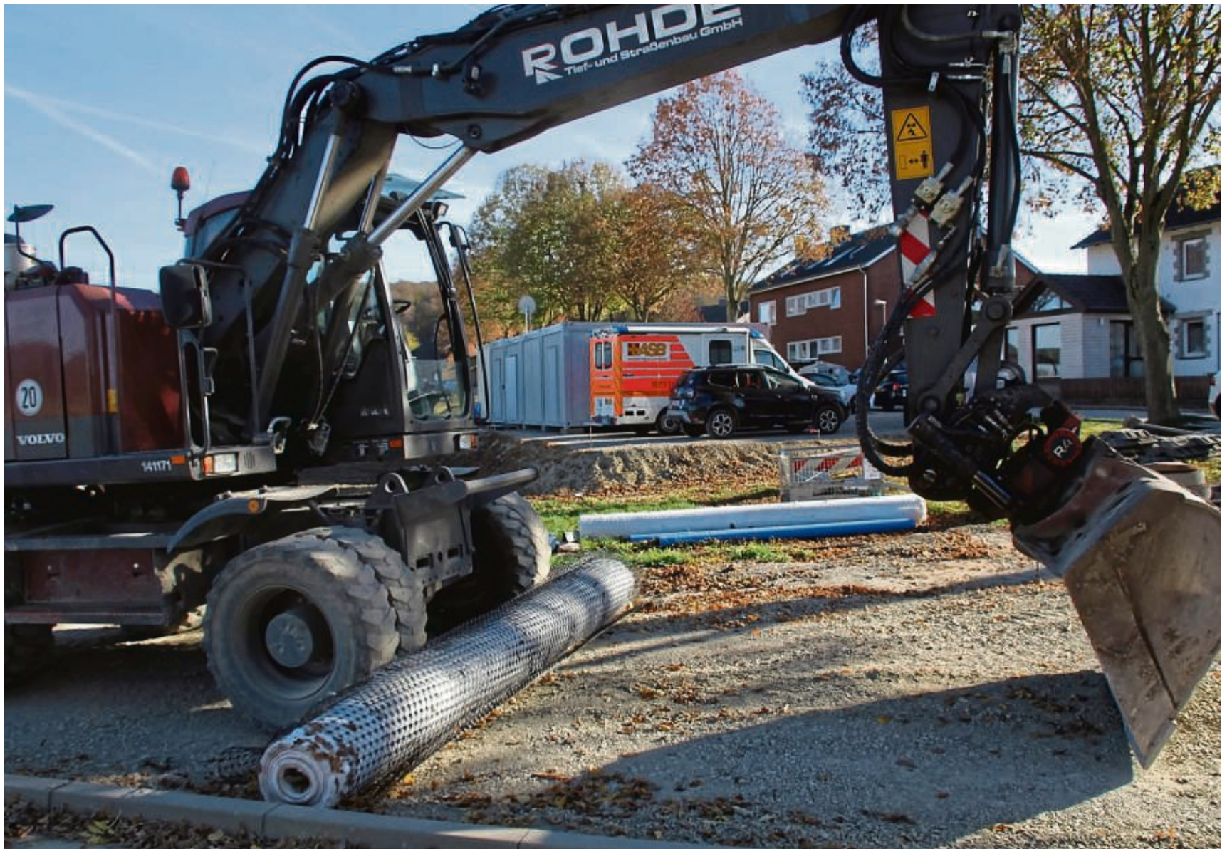
Neue Rettungswache ASB in Oberlistingen: Hier an der Baustelle an der Arolser Straße/Ecke Igelsbettweg stehen jetzt Container für die Rettungs- und Notfallsanitäter. Dort soll ein neues Feuerwehrhaus für die Listinger Wehr (Oberlistingen und Niederlistingen) und eine Tagwache des ASB entstehen.
