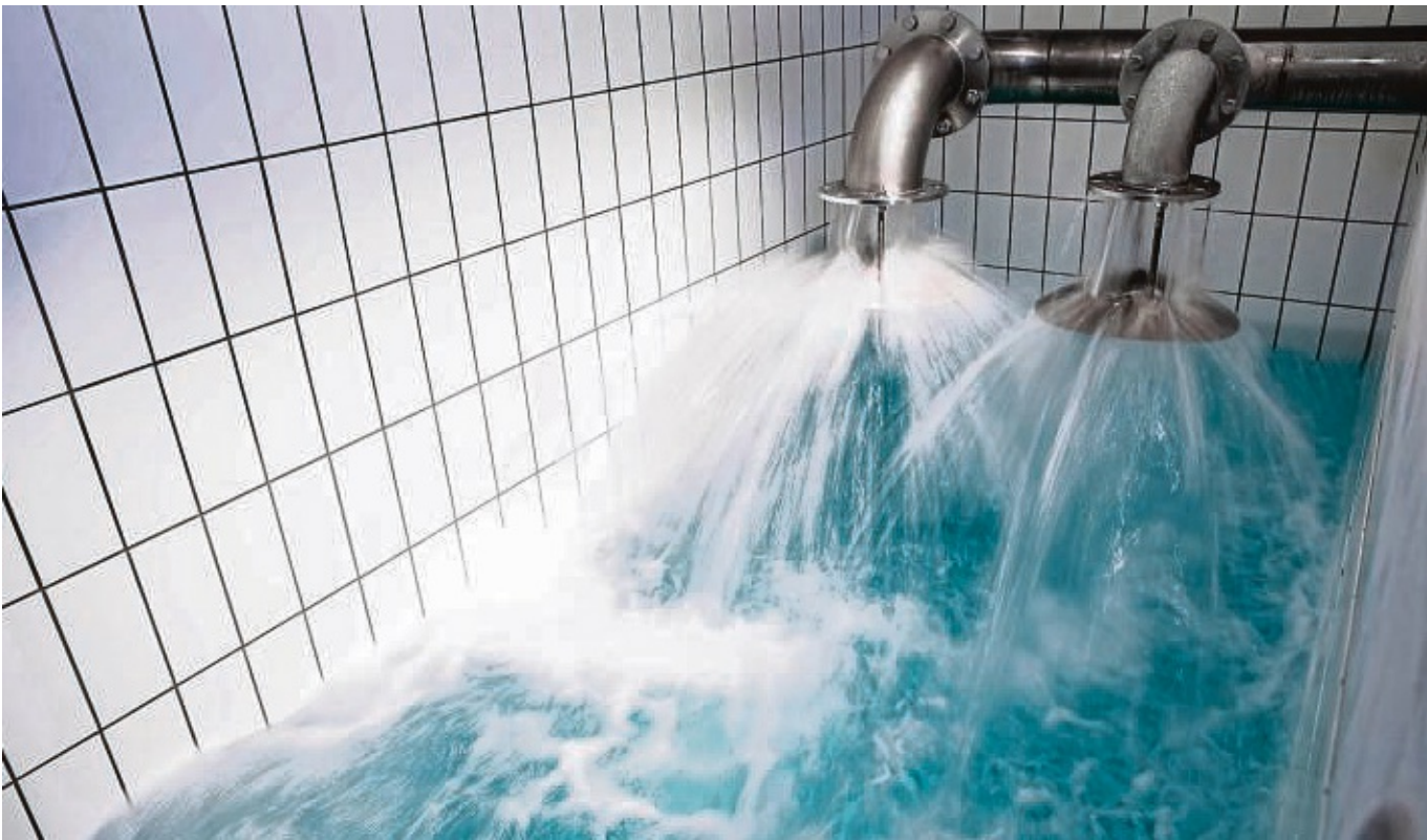
Wichtigstes Lebensmittel: Wasser in einer Wildunger Versorgungsanlage.
