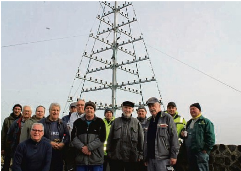
Erfolgreicher Arbeitseinsatz: Arbeitskreismitglieder und weitere Helfer stellten auf der Felsburg die einem Tannenbaum nach empfundene Metallkonstruktion auf. 192 Glühbirnen sind an der Konstruktion angebracht.
