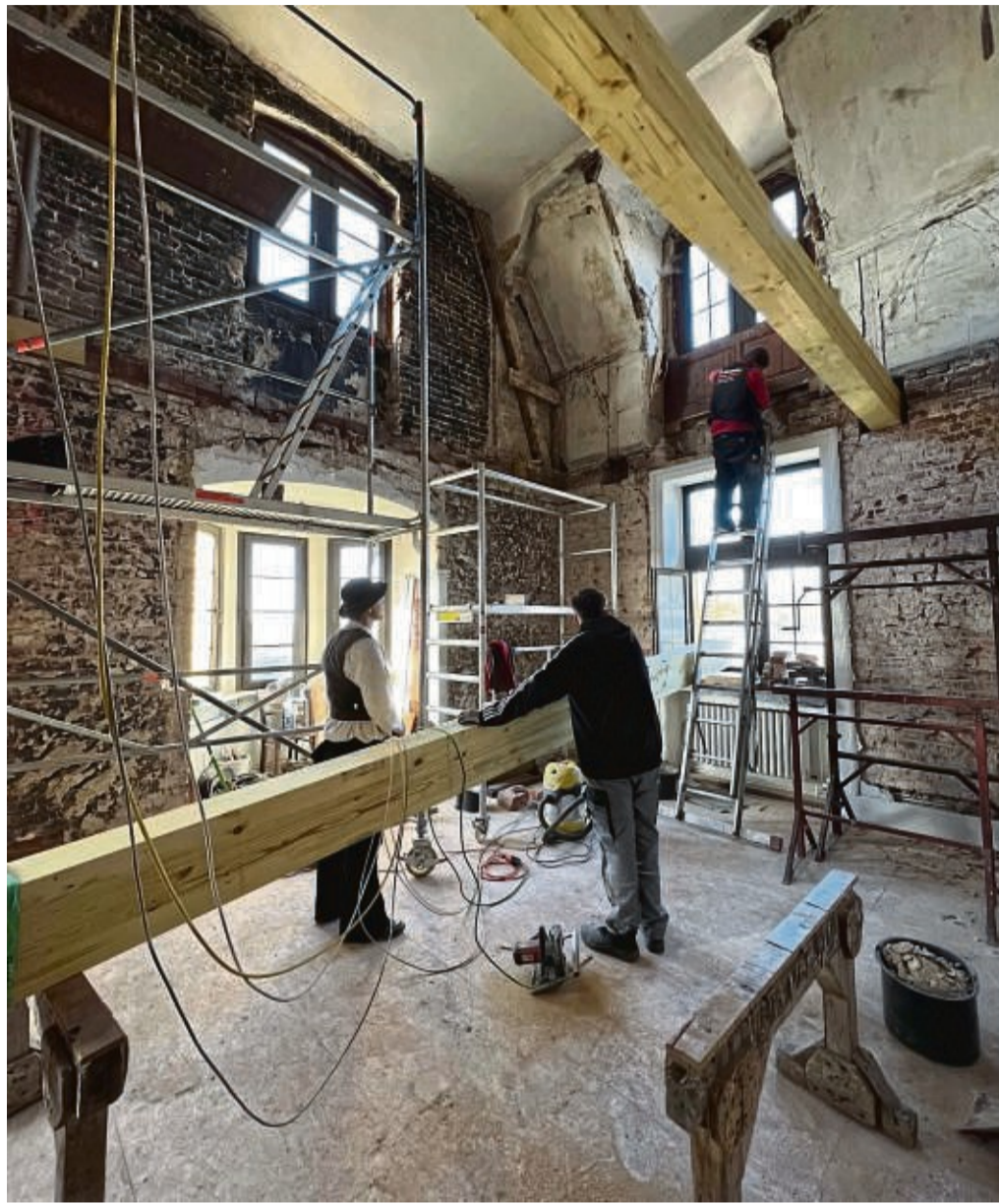
Neue Balken als Boden für das Klavierzimmer schwebten per Kran in das Schloss. Mittlerweile ist die Decke verschlossen.
