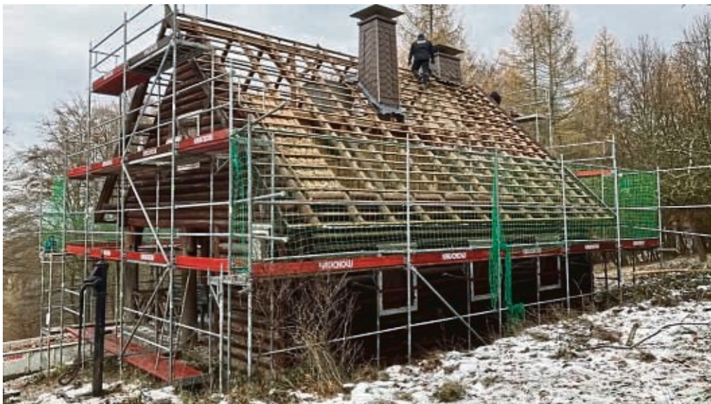
Eingerüstet für den Abbau: die Charlottenhütte.
